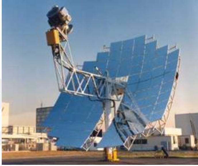
Şekil 3.16. Merkezi alıcılı çanak kolektörlerin yapısı.
