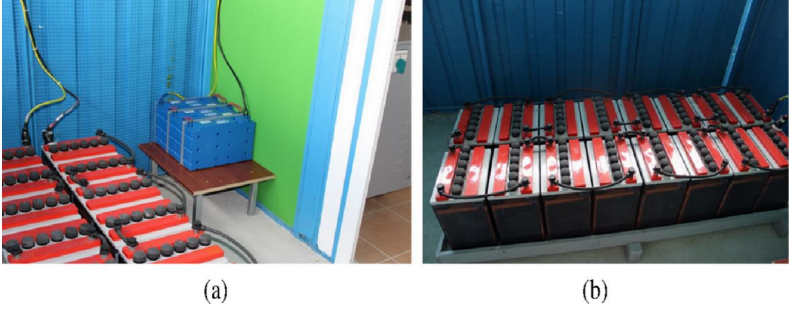
Şekil 4.4. Depolama birimleri (a)Ultra Kapasitörler (b) Batarya Grubu.
