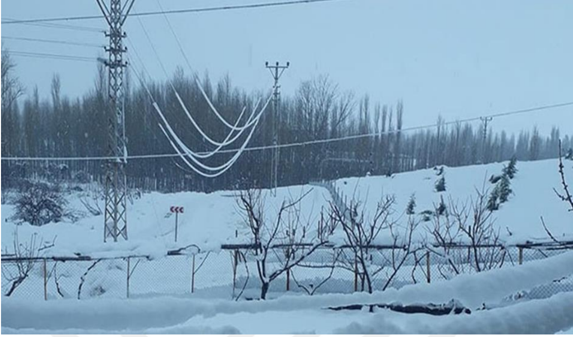
Şekil 4.32. Kar yağışından bağlı olarak hat kopma arızaları
